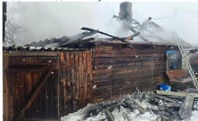
**23 января в 02:51** произошел пожар в доме на хуторе в д. Судиловичи. В результате возгорания огнем повреждено деревянное перекрытие над печью. **Причина пожара – нарушение правил использования печей, теплогенерирующих агрегатов и устройств (перекал печи).**
